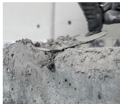
5. Lissage avec une taloche caoutchouc
