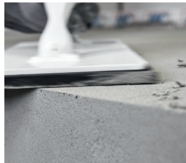
5. Lissage avec une taloche caoutchouc
